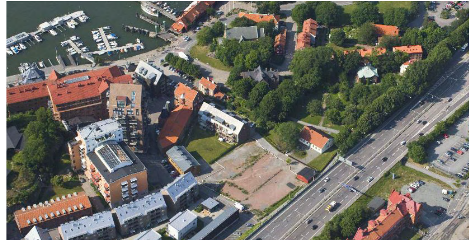
Sedan ladugårdslängorna brunnit ner består planområdet i huvudsak av en obebyggd parkeringsyta. På sned bilden syns en mindre kvarvarande del av en av ladugårdslängorna som klarade sig i branden. Denna revs 2020 till följd av eftersatt tekniskt skick. Källa: SBF 2022.
